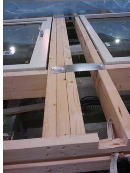
Foto 2: Yttervägg med sammansatta regler
