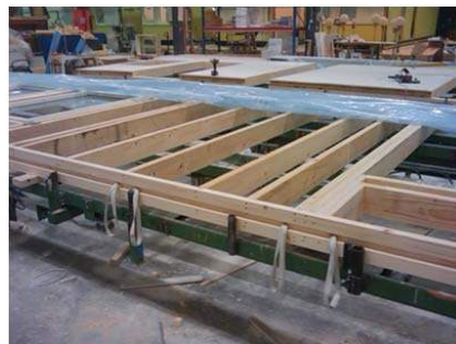
Foto 3: Yttervägg med sammansatta regler
